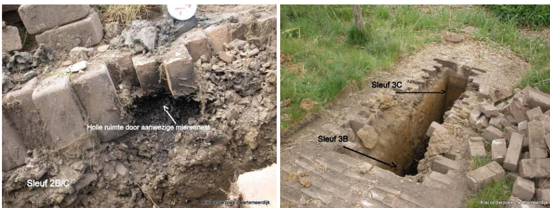
Figuur 2.2 Buitentalud en bekleding van de Zwartemeerdijk (foto's van Arcadis)
