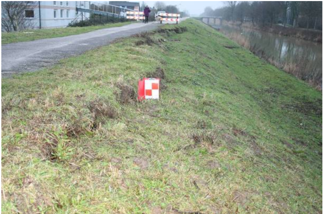
Afgeschoven talud kanaalkade regionale keringen (nabij primaire kering)
