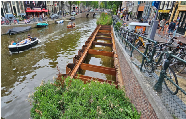
Figuur 19: Reinforcement of the canal wall at the Oudezijds Voorburgwal (Gemeente Amsterdam, 2024)
