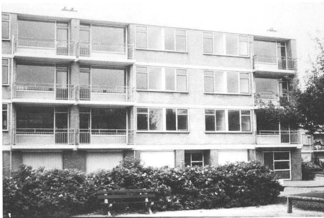
Hoogeveen, Eiber e.o., 450 woningen, huurderving in het totale administratieve complex in 1985 10,0%, leegstand per 26 juni 1987 16,2%. De leegstand koncentreerde zich echter in 6 flatgebouwen aan de Eiber (73 van de 144 woningen stonden hier leeg). Foto juni 1988.
