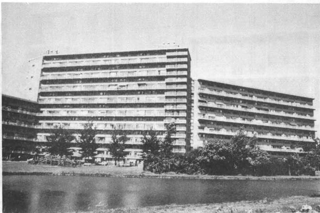
Gorinchem, Dr. van Stratenweg, 418 woningen, huurderving in 1985 20,1%, leegstand per 31 mei 1987 37,2%. Foto augustus 1987.
