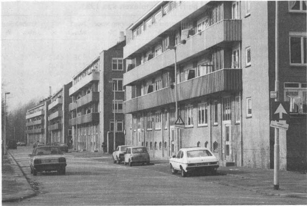
Hoogvliet, Nieuw Engeland, 1062 woningen, huurderiving in 1985 8,6%, leegstand eind augustus 1987 17,7%. Inmiddels zijn er konkrete plannen voor gedeeltelijke sloop (en gedeeltelijke renovatie en groot-onderhoud). Foto 1987.
