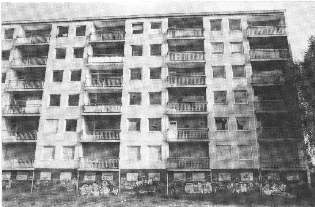
Helmond, kompleks De Jagershoven, 384 woningen. Dit kompleks wordt binnenkort gesloopt n.a.v. de leegstandsproblemen. Precieze leegstandscijfers zijn ons niet bekend door het ontbreken van het jaarverslag van de desbetreffende korporatie. Foto's november 1987.
