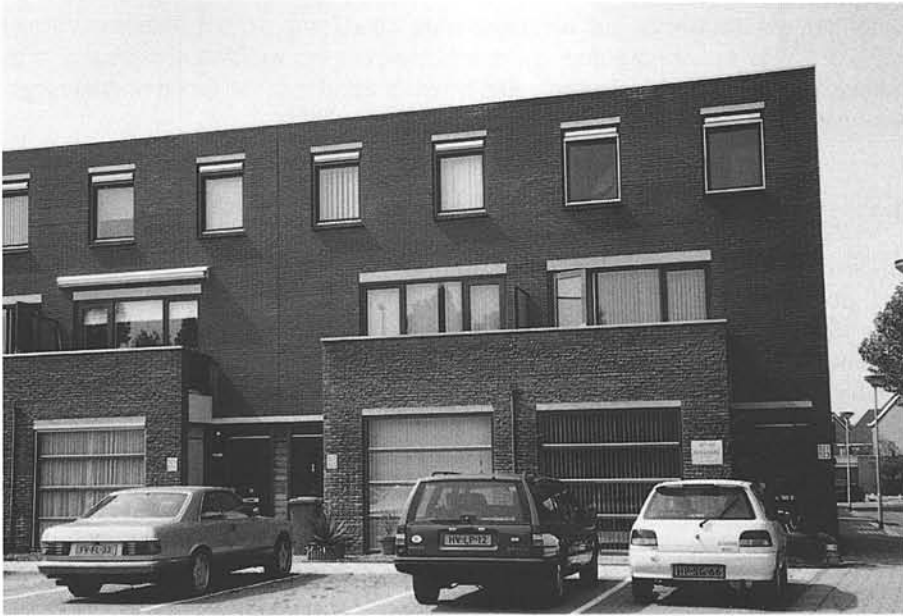
Afbeelding 4.1 Atelierwoningen in de Rotterdamse wijk Zevenkamp. Per woning zijn twee parkeerplaatsen aanwezig. Sommige bewoners hebben bij hun parkeerplaatsen bordjes met de tekst “privé parkeerplaats” geplaatst (niet zichtbaar op de foto).
