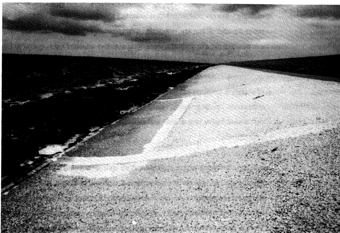
Fig. 12. Overzichtsfoto van de opgeleverde bekleding
