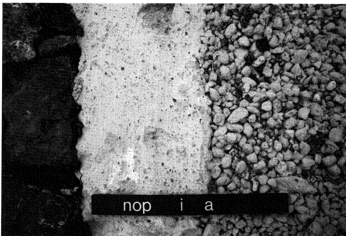
Fig. 5. Detail van de randaansluiting op de bestaande basaltbekleding
