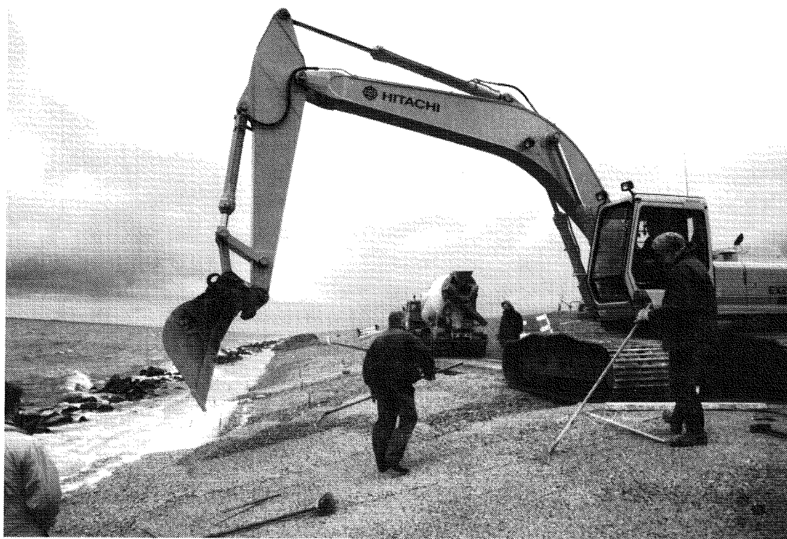
Fig. 7. Spreiden van colloïdaal beton met een hydraulische kraan
