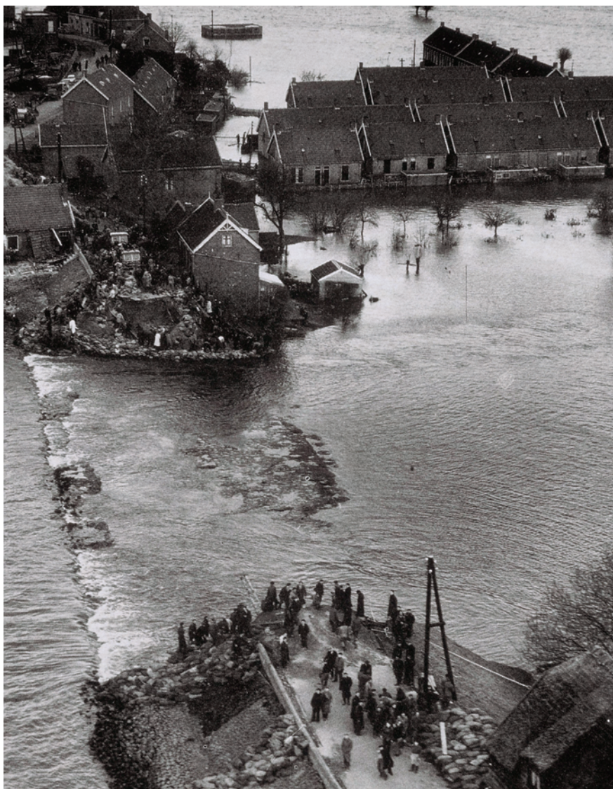
Dijkdoorbraak bij Den Bommel (Goeree Overflakkee) Bron: www.BeeldbankVenW.nl , Rijkswaterstaat.
