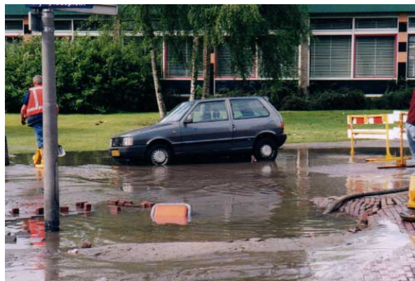
Fig. 8 - Overlast door leidingbreuk
