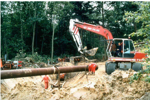
Fig. 6 - Moderne aanleg van een transportleiding: gemechaniseerd en minder arbeidsintensief
