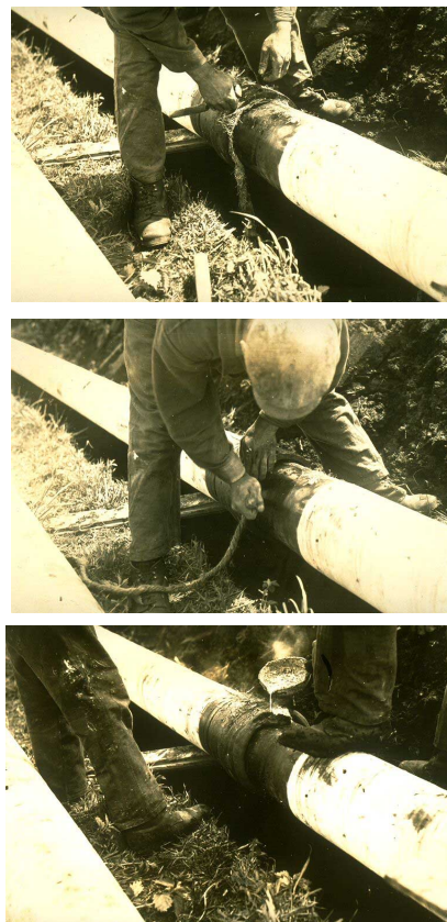
Fig. 3 - Maken van lood-striktouwverbindingen: vakmanschap is een vereiste
