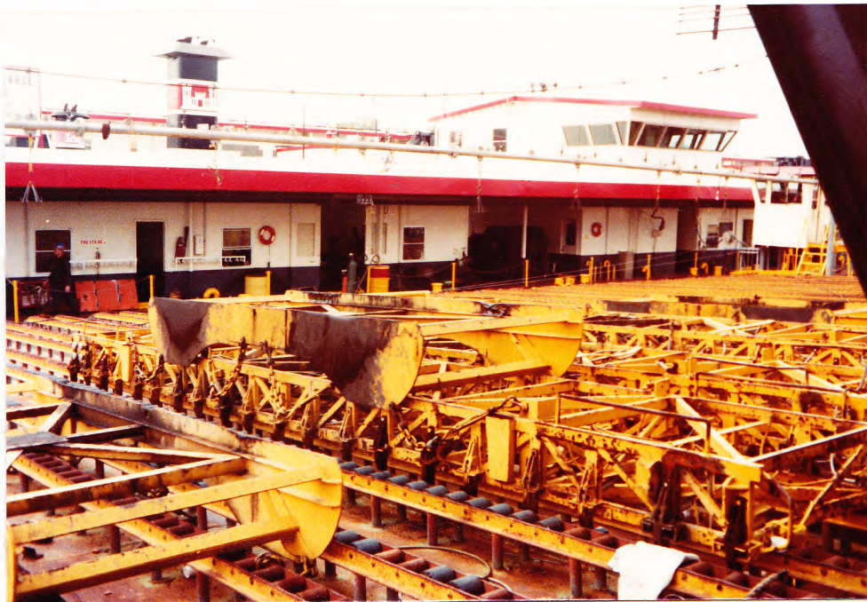
Klemkonstruktie voor het oppakken van de betonplaten.
