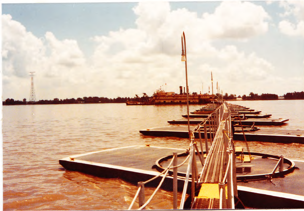
Afvoer specie via drijvende leiding.
