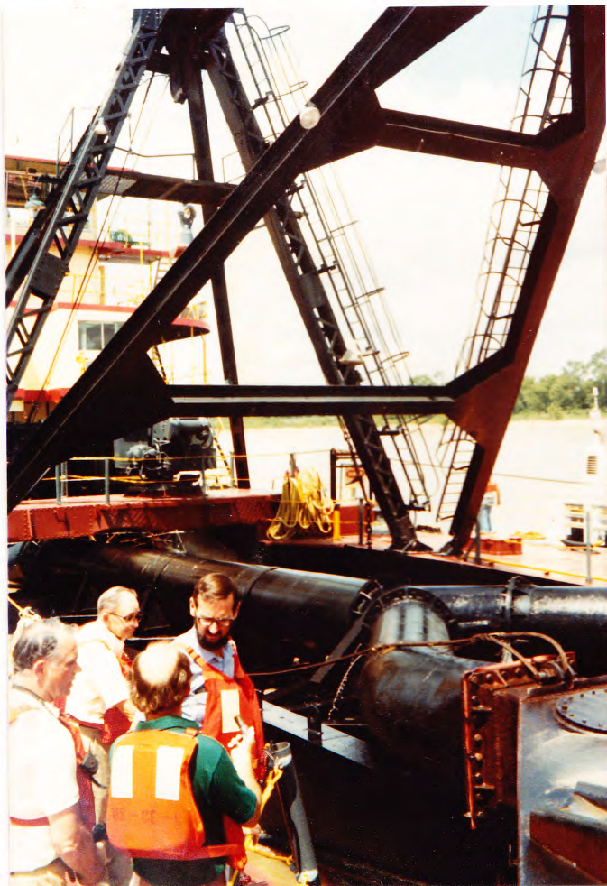
Zuigleiding met duidelijk zichtbaar het bijeenkomen van de twee leidingen.
