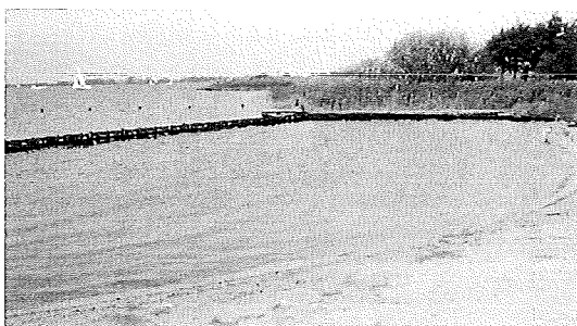
Figuur 12.8: Uitvoering palenrijen
