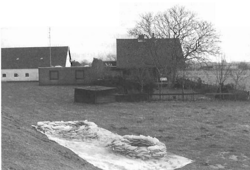
Bij een zandmeevoerende wel moet de wel opgekist worden; er wordt een kade van zandzakken gemaakt.
