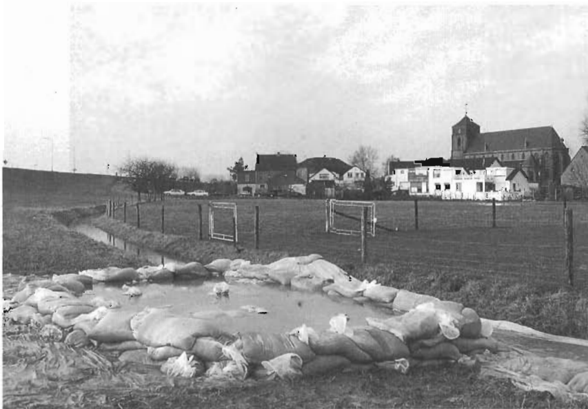
Als er wel is geconstateerd, moet deze afgedekt worden met geotextiel en zandzakken.
