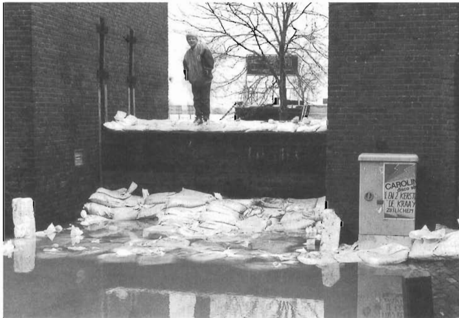
Een coupure in de dijk is gemakkelijk te controleren op lekkage.
