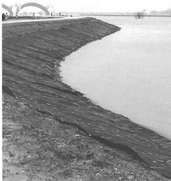
Als er water uit het talud komt, moet de grond worden afgedekt met geotextiel en zandzakken.
