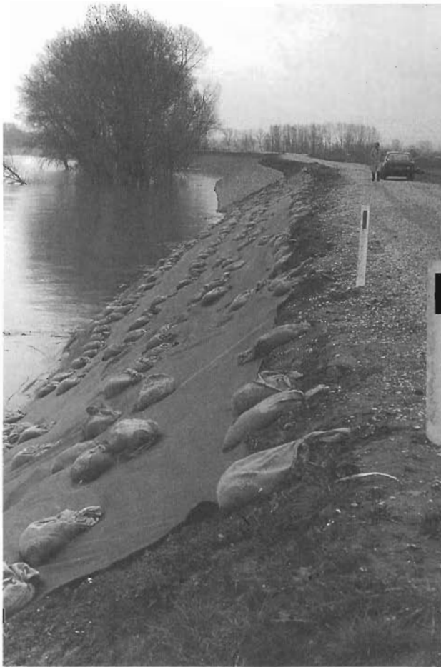
Afdekking met geotextiel of folie moet aan de randen worden geballast.
