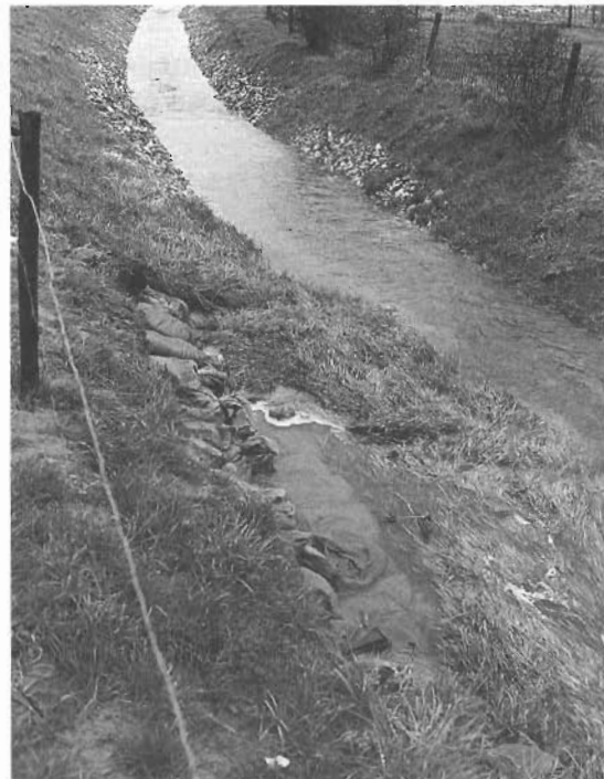
Als er behalve water ook grond meekomt, moeten de gaten worden gedicht met zandzakken.
