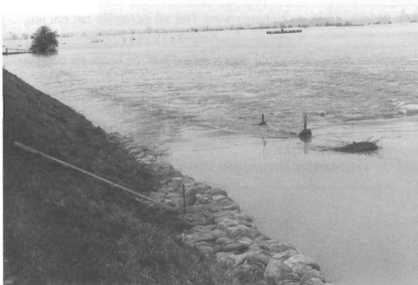
Gaten die dieper zijn dan 20 cm, waar geen zand uitkomt, moeten opgevuld worden met zandzakken.
