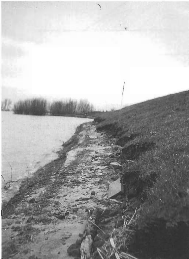
Tijdens hoogwater kan de grasmat geschadigd worden door golven en stroming of door drijfvuil.
