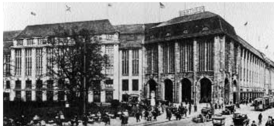
Afbeelding 3.10 Warenhuis Wertheim (Berlijn, 1904), foto exterieur. Ontwerp: A. Messel (1904) en E. Schmohl (uitbreiding, 1927). Bron: Gerlach, 1988, afbeelding 15.
