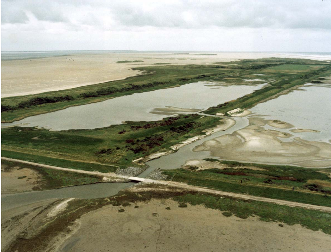
Vliegerfoto ( Jaap de Vlas) van een deel van de derde en van de vierde polder, waarop de doorgestoken dijken te zien zijn.
