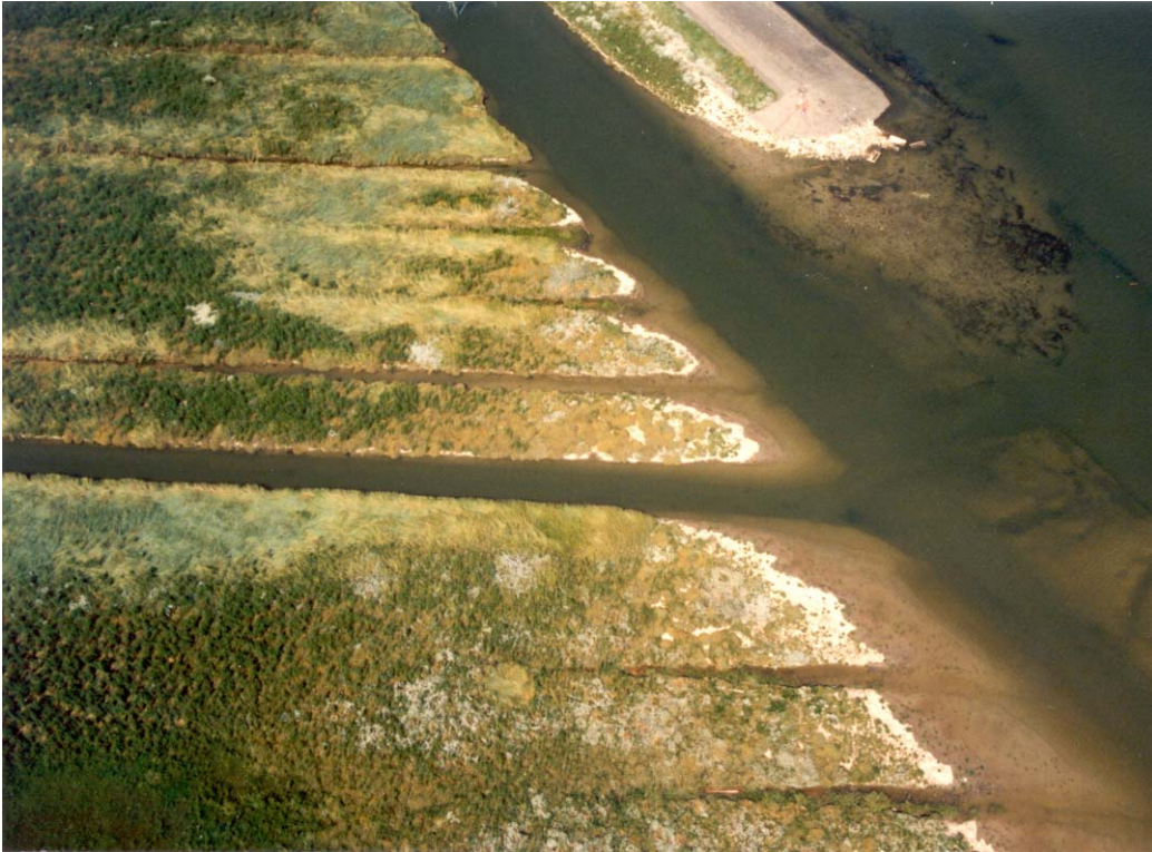
Vliegerfoto van de verwoeste bitumendijk bij de Peazemerlannen (Foto: Jaap de Vlas)
