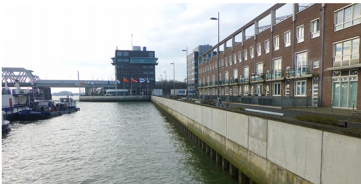
Kade in Zwijndrecht langs de Oude Maas. Onder de kade is een parkeergarage gesitueerd.
