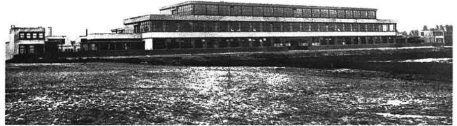
3 J.G. Wiebenga en L.C. van der Vlugt, Groningen 1922-24. MTS-Ambachtsschool. Overkraging van de verdiepingen. Gewijzigde toestand. Technical School. Cantilevered upper floors. Following modifications.
