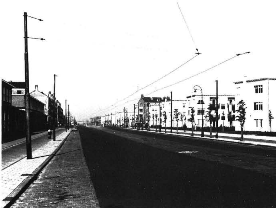
25 Burgemeester de Vlugtlaan, Slotermeer, Amsterdam ± 1953. Systeembouw, ontworpen door J.F. Berghoef (rechts). Het woongebouw daartussen, in traditionele bouw, is van A. Staal, Foto 1954. Systems building designed by J.F. Berghoef (right). The housing block in between, built according traditional methods, is by A. Staal.
