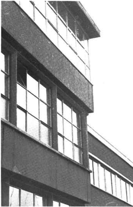
3 J.G. Wiebenga en L.C. van der Vlugt, Groningen 1922-24. MTS-Ambachtsschool. Overkraging van de verdiepingen. Gewijzigde toestand. Technical School. Cantilevered upper floors. Following modifications.
