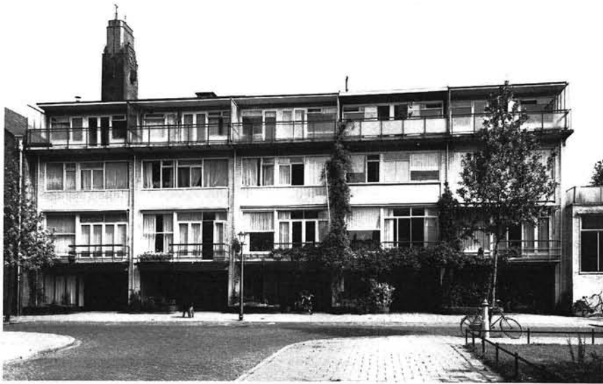
32 W. van Tijen, M. Stam en L. Stam- Beese, Amsterdam 1935. Drive-in woningen Anthony van Dijkstraat. Town houses in Anthony van Dijkstraat.
