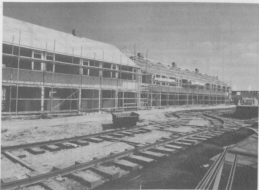
Woningen van het type met wisselbeuk in aanbouw van het experimentele complex met 626 woningen te Zoetermeer. Slokker Bouw Maatschappij NV, augustus 1970. De gevels en het dak zijn in bewerking. Foto: M. Germann, Abstede C.V., Utrecht.
