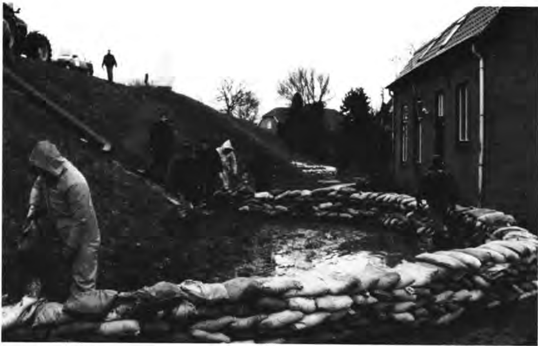
Fig. 1. Meer inzicht in conditie van de dijk door middel van monitoring.
