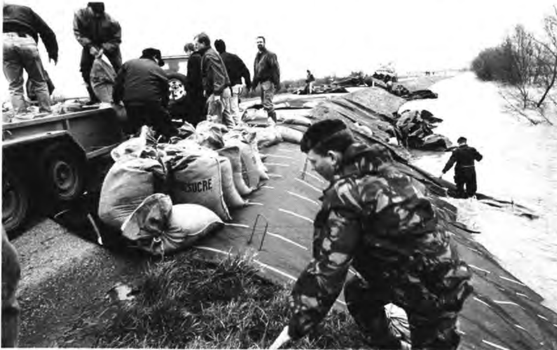
Fig. 13. Geotextiel vastzetten met pennen en zandzakken.
