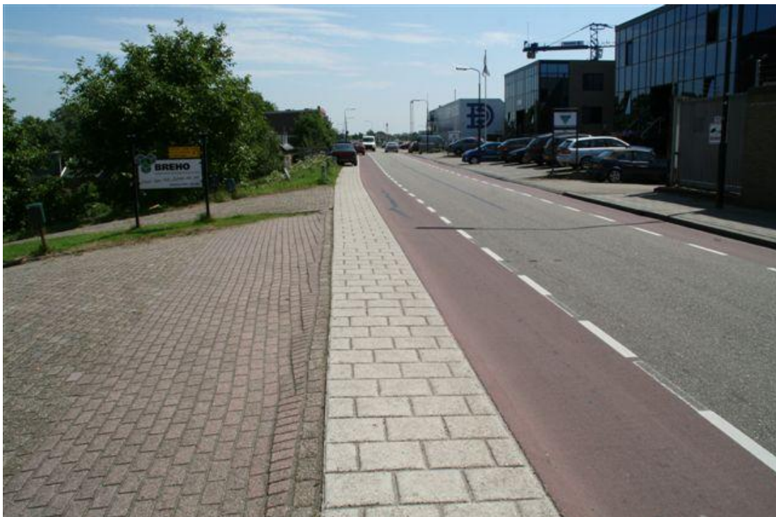
Figuur A.26 Hardingsveld-Giessendam. Iets meer naar het westen (zie Google overzicht). Links het binnentalud, rechts de rivierzijde. Onder de wit/grijze klinkers een 26 m diepe damwand om oude huizen op het binnentalud te sparen.
