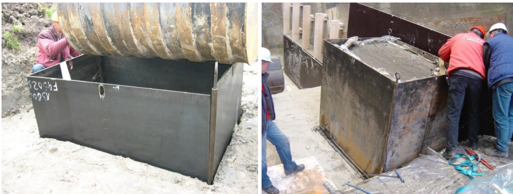
Figuur 6.1 Links: stalen mal wordt op de dijk in de keileem gestoken. Rechts: blok keileem geplaatst in de Deltagoot
