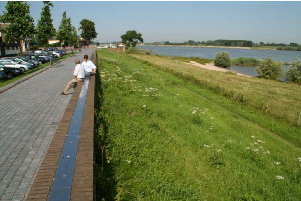
Figuur A.4 Waalkade Zaltbommel. De bovenkant muur geeft MHW aan. Tijdens hoogwater wordt de muur verhoogd met een flexibele kering. Tijdens MHW ligt het grastalud dus volledig onder water.
