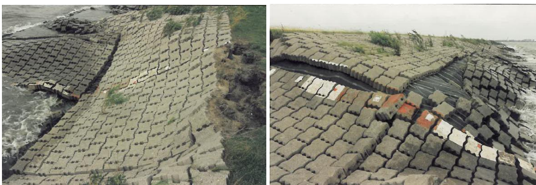
Figuur 3.10 Proefvakken Armorflex (links) en Betomat (rechts) op Houtribdijk (situatie najaar 1991)
