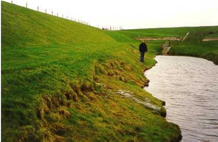
Figuur 2.4 Microinstabiliteit als initieel mechanisme. De bekleding is opgedrukt en afgeschoven
