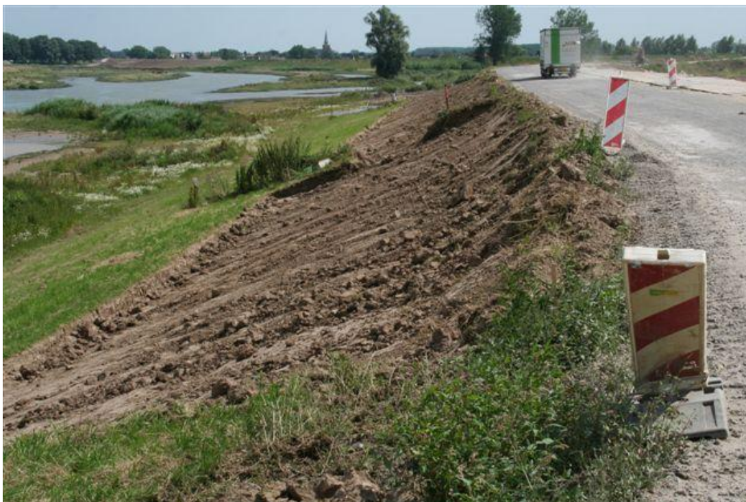
Figuur A.40 Lek bij Achthoven. Werk in uitvoering. Groene dijk met weg op de kruin.
