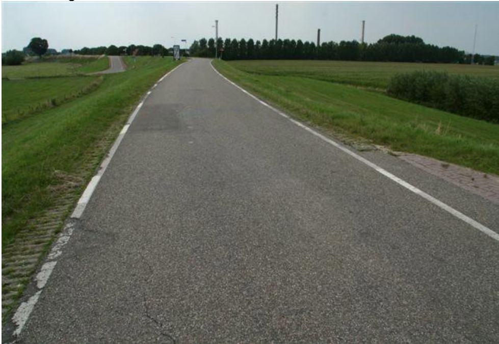
Foto 1.1 Noordzijde Waaldijk bij Lingewaal. Buitentalud gras (links op foto). Weg op de kruin van de dijk. Verharde afrit aan rivierzijde, links-boven op de foto.
