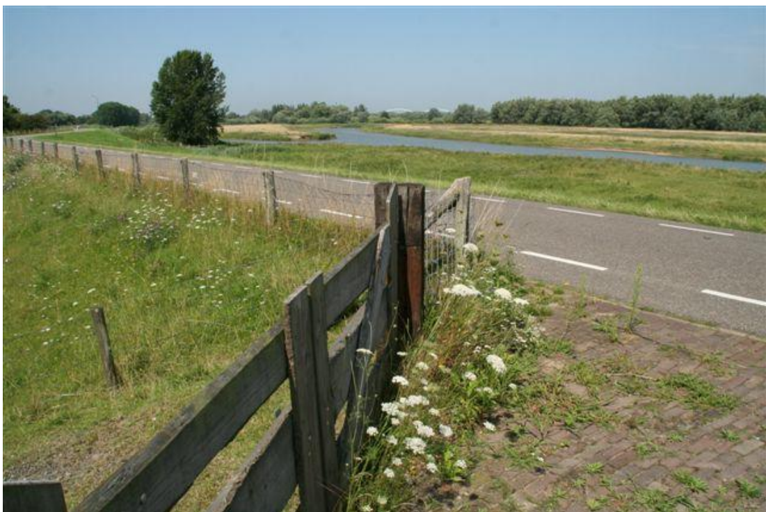
Figuur A.18 Merwede ten westen van Woudrichem. Rivierzijde: een groene dijk met een weg op de kruin.
