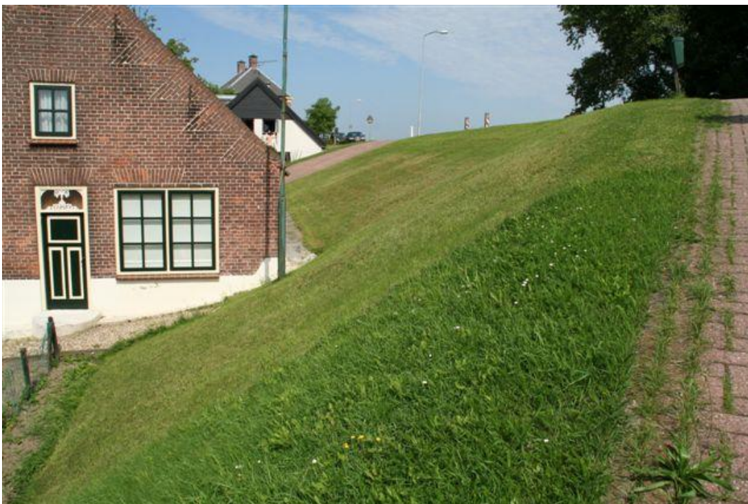
Figuur A.12 Waaldijk bij Zuilichem. Binnenzijde van de dijk. Veel op- en afritten en huizen in het talud. Om de huizen te sparen is een stabiliteitsscherm in de dijk aangebracht tot 1 m beneden de kruin. Op de dijk ligt een weg.
