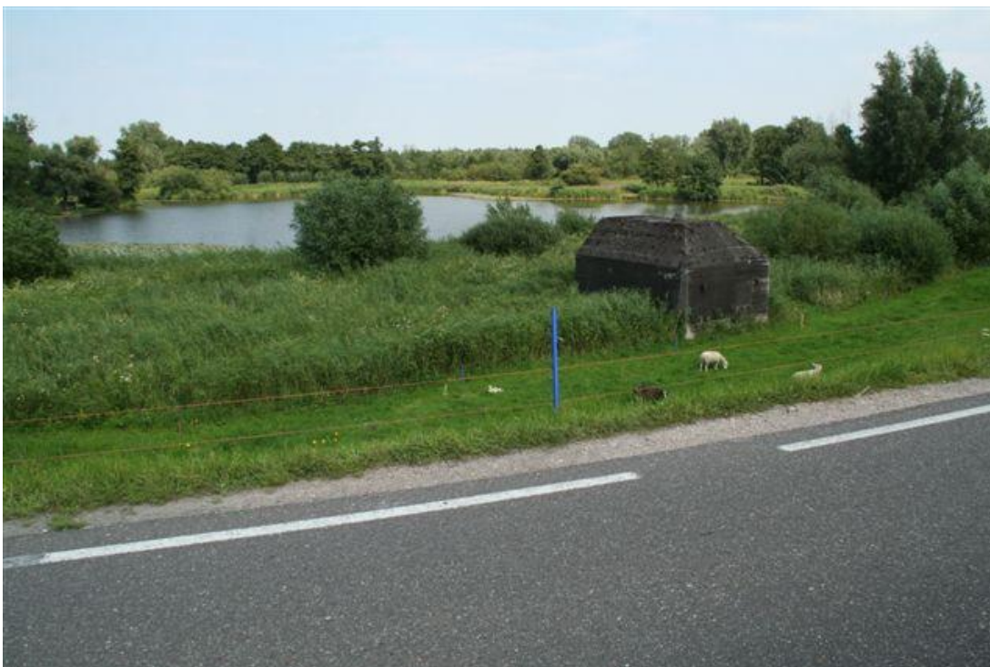
Figuur A.48 Diefdijk met wiel aan oostzijde. Groene dijk met weg op de kruin van de dijk.
