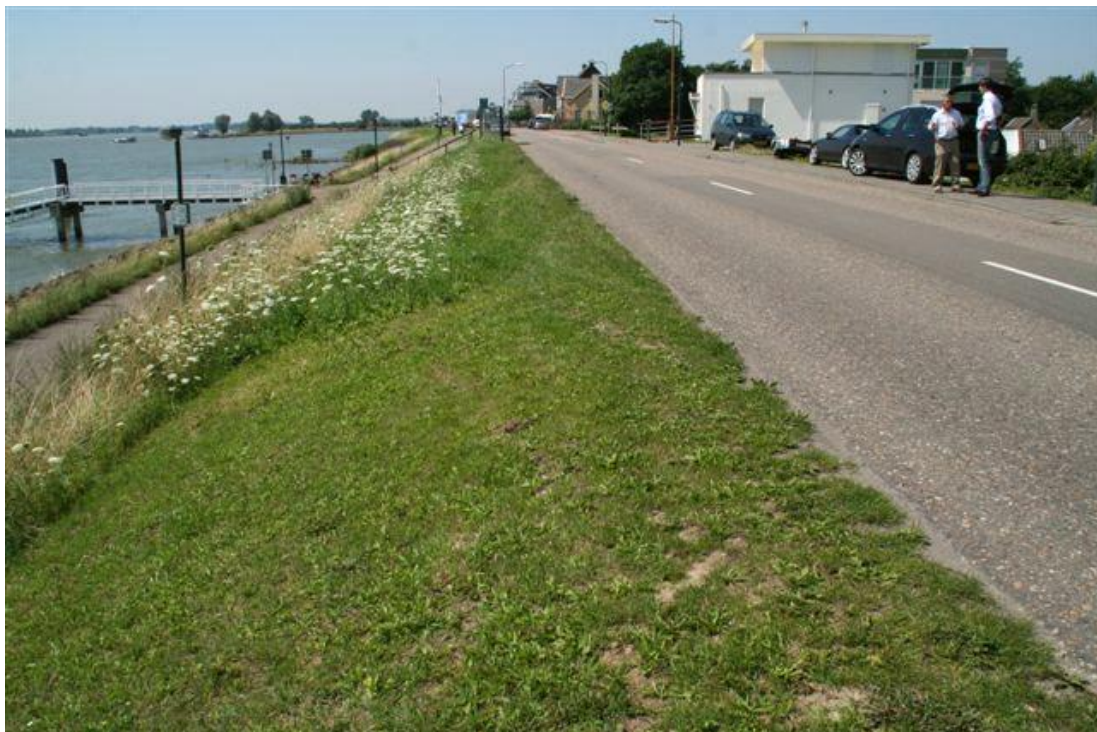
Figuur 2.13 Hardinxveld-Giessendam. Rivierzijde: gras met een brede weg op de kruin. Aan rivierzijde een trapje naar de steiger en verderop komt het fietspad op de weg uit (op/afrit). Bebouwing langs de binnenzijde.
