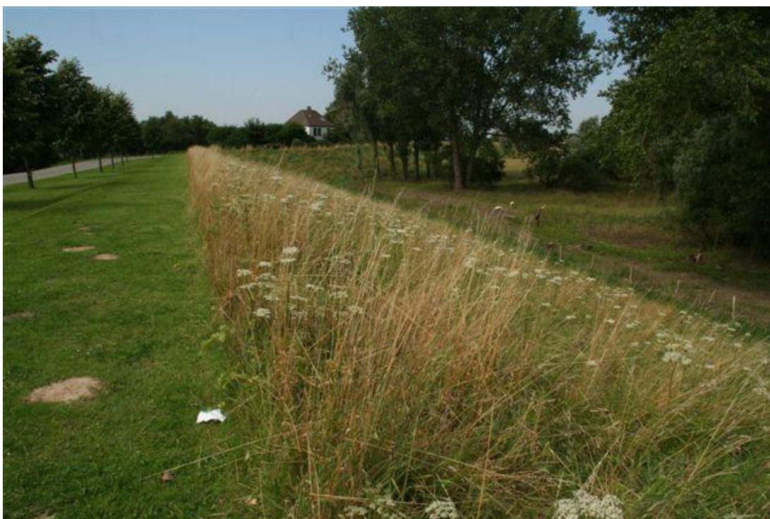
Figuur A.15 Waldijk westzijde van Zuilichem. Buitenwaarts verhoogd. Het hoogbegroeide deel is de dijkverhoging met rechts het talud aan de rivierzijde. Voorland met bomen. Op deze dijk is geen weg aanwezig.
