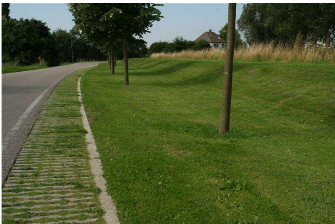
Figuur A.14 Waldijk westzijde van Zuilichem. Buitenwaarts verhoogd. De verhoging is ongeveer 1 m. Binnenzijde van de verhoging.
