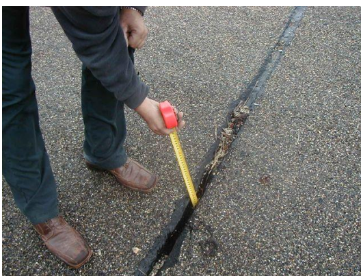
Figuur 3.3 links: geregeld voorkomende naden in asfalt; rechts: zeer zeldzame beschadiging van zandasfalt.
