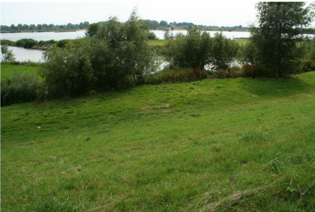
Figuur A.32 Noordzijde Waaldijk bij Lingewaal bij TG346. Buitentalud gras. Weg op de kruin van de dijk.
