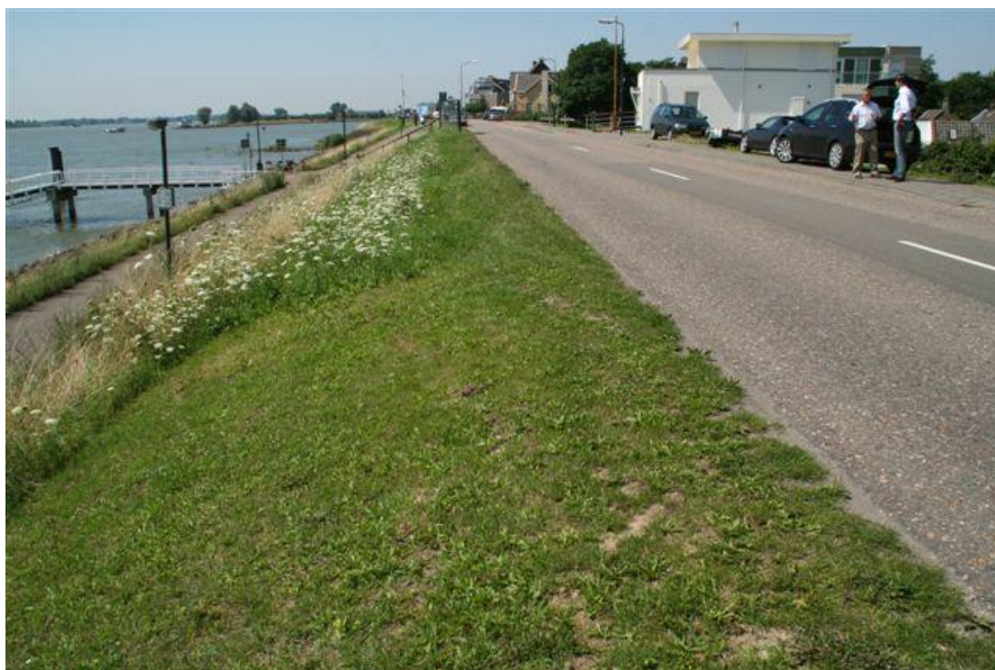
Figuur A.24 Hardinxveld-Giessendam. Bebouwing langs de binnenzijde. Rivierzijde: gras met een brede weg op de kruin. Aan rivierzijde een trapje naar de steiger en verderop komt het fietspad op de weg uit (op/afrit).
