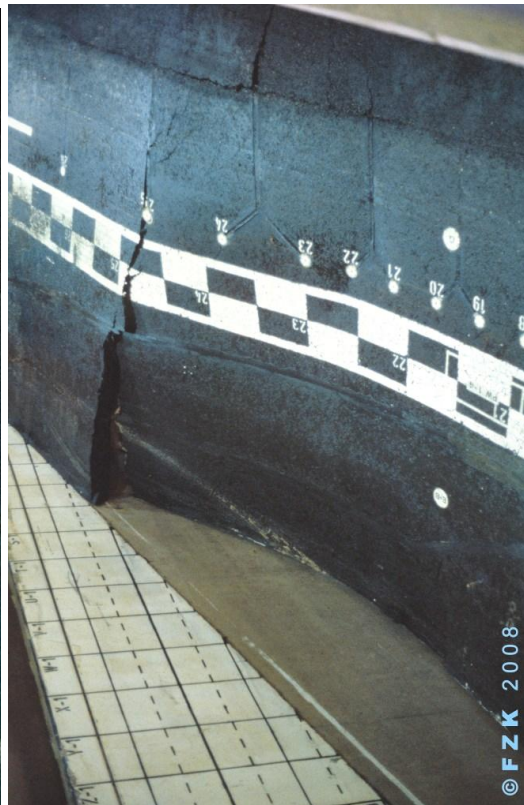
FZK, Versagen der Asphaltdecke, Bild 3
