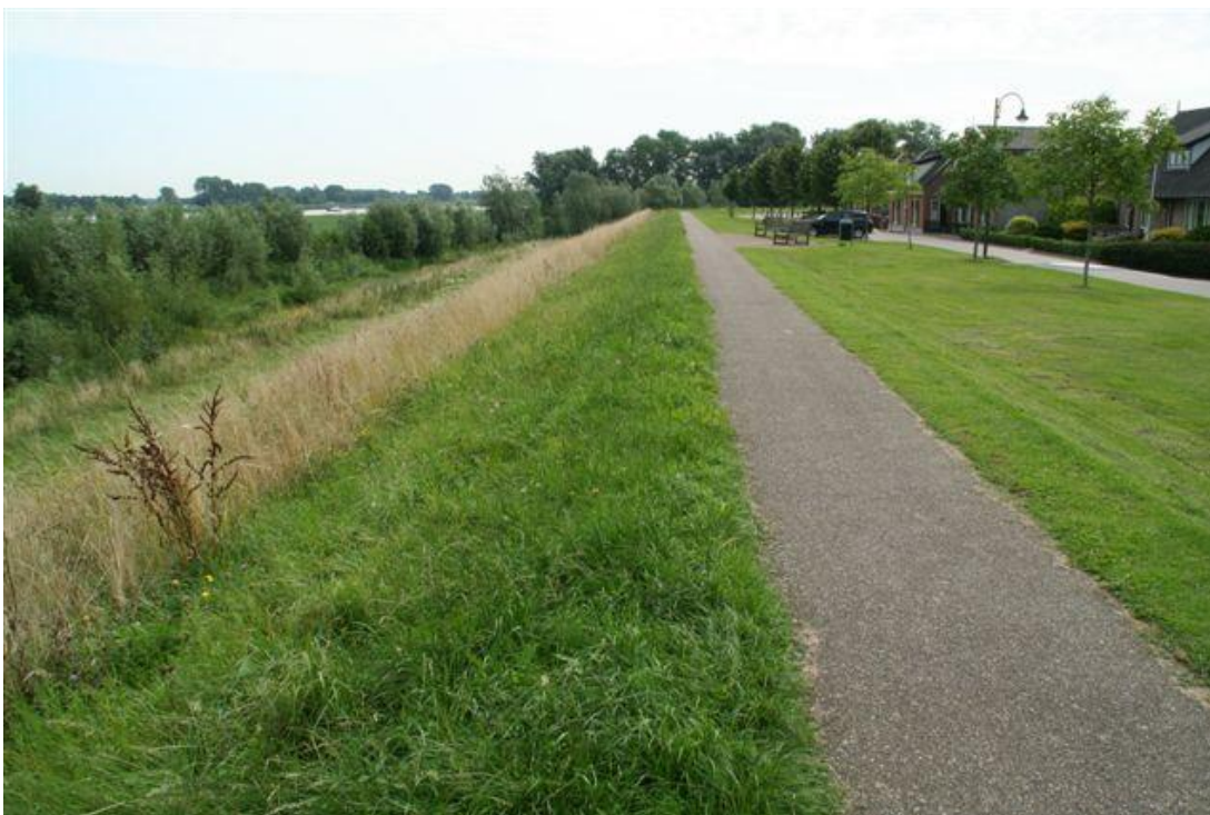
Figuur A.20 Brakel. 160 huizen gesloopt om plaats te maken voor dijkverzwaring. Verhoging is ongeveer 1 m. Links de rivierzijde van de dijk. Op de dijk ligt een fietspad.
