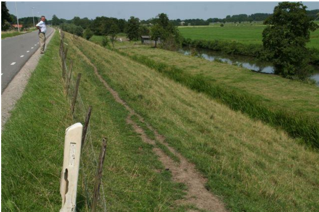
Figuur A.46 Noordzijde Diefdijk. Compartimenteringsdijk. "Rivierzijde" bij DL006. Groene dijk met afrastering nabij de kruin, een schapenpaadje en een weg op de kruin van de dijk.
