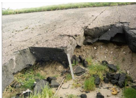
Figuur 3.3 links: geregeld voorkomende naden in asfalt; rechts: zeer zeldzame beschadiging van zandasfalt.
