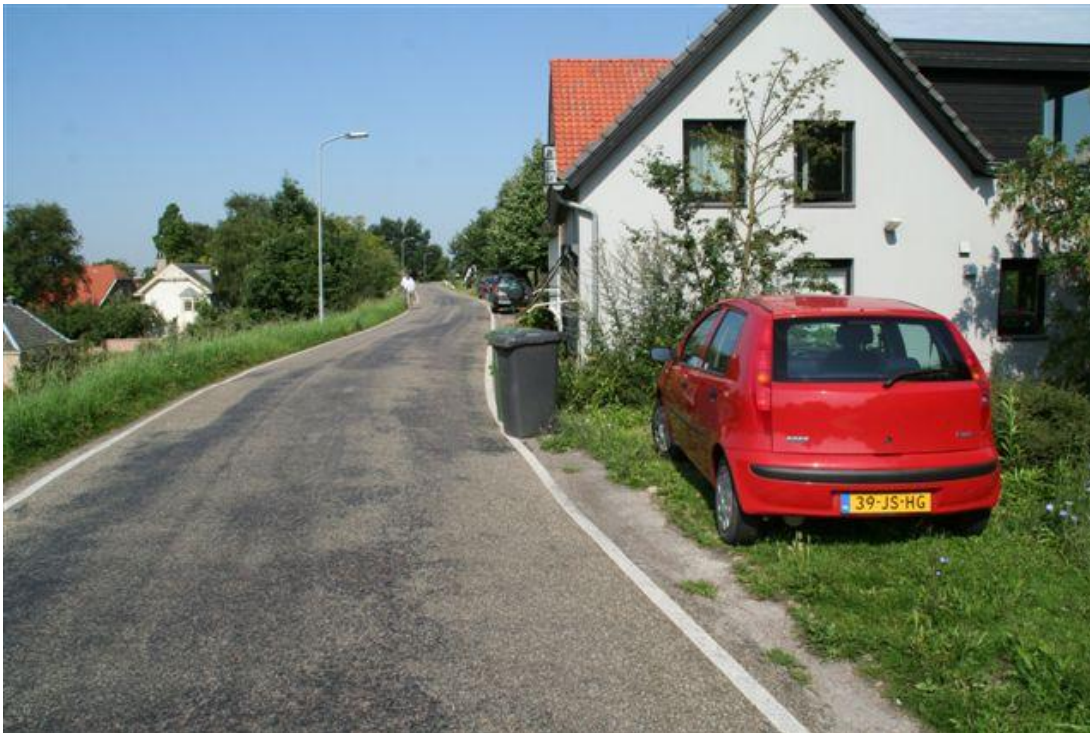
Figuur A.7 Bandijk langs de Waal bij Zaltbommel. Kering niet meer in functie. Bebouwing langs de rivierzijde (rechts).
