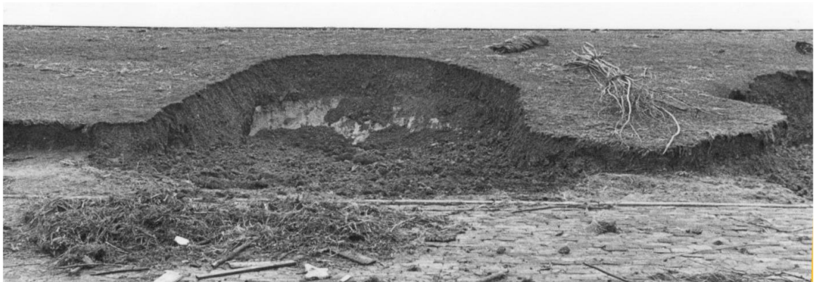
Figuur 3.16 Detail van diepste gat in buitentalud uit Figuur 3.15
