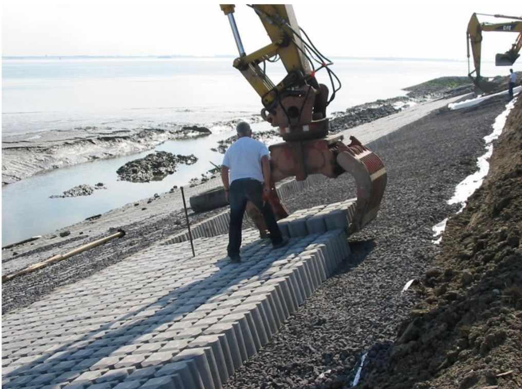
Figuur 1.2 Aanleg van een steenzetting op granulair filter
