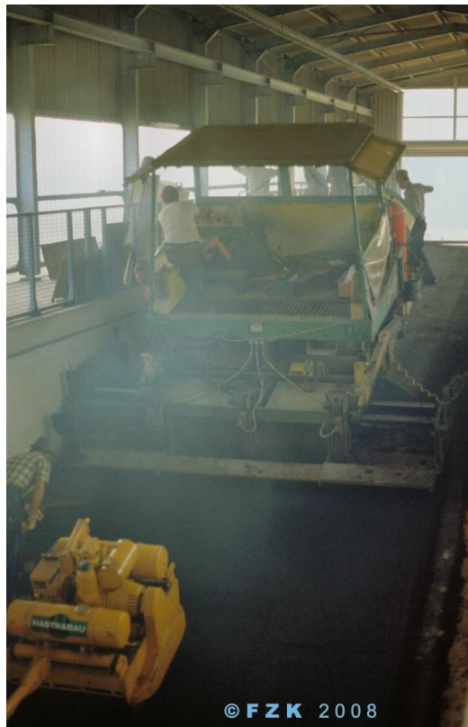
FZK, Bau des Asphaltdeichs, Bild 2.jpg
