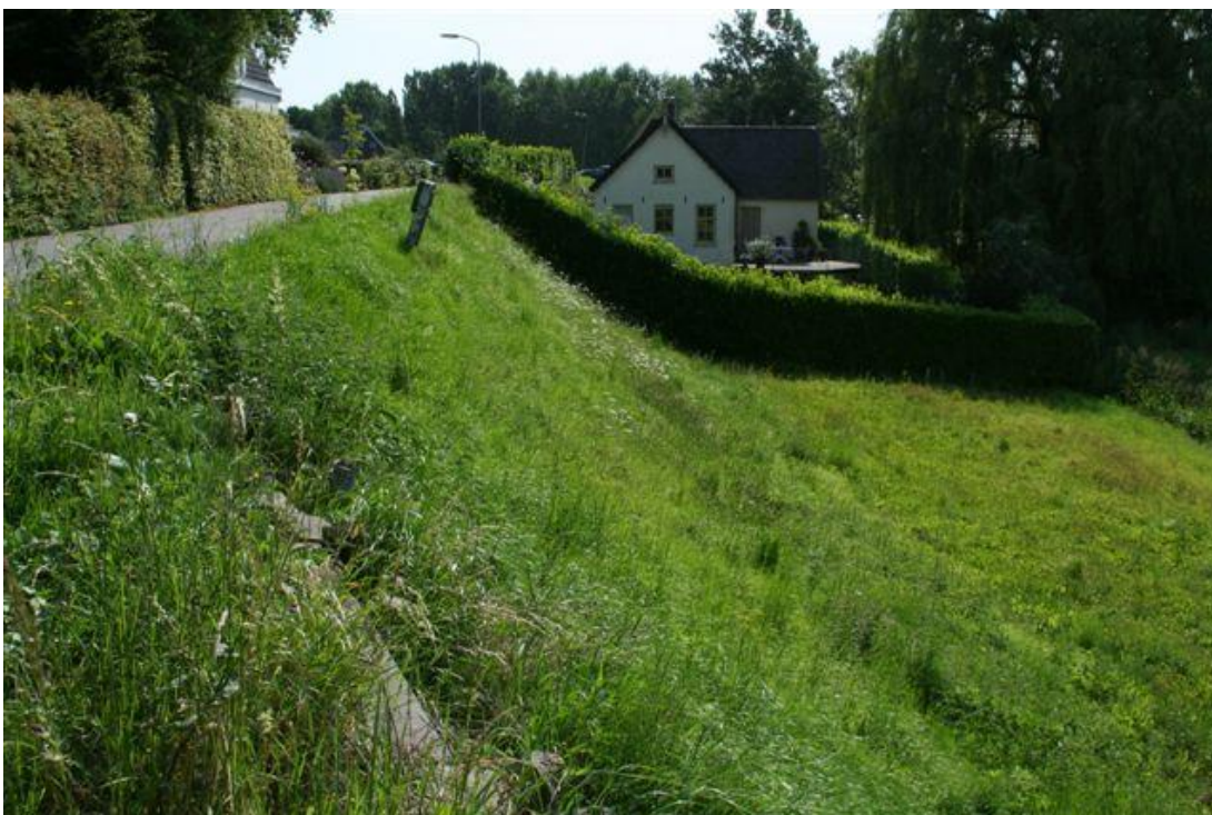
Figuur A.8 Bandijk langs de Waal bij Zaltbommel. Kering niet meer in functie. Binnenzijde van de dijk met bebouwing. Links-boven op de foto: bebouwing en beplanting op de rivierzijde.
