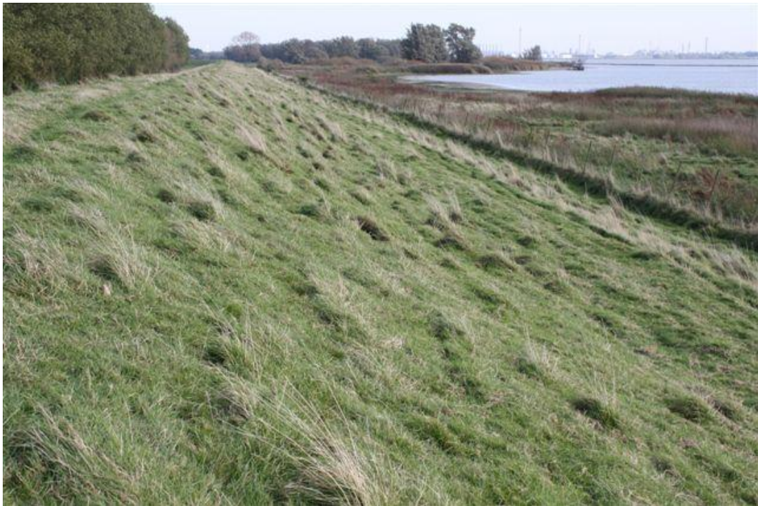
Figuur A.52 Hollands Diep. Oostzijde van het dijkvak. Rivierzijde, ruige begroeiing, geen weg op de dijk.
