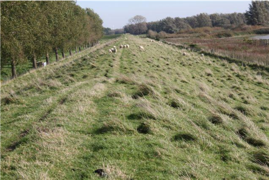
Figuur A.54 Hollands Diep, halverwege het dijkvak. Een dijkval van ongeveer 0,6 m. Reden/oorzaak van lagere kruin niet bekend. Ruige begroeiing. Schapen op de dijk.
