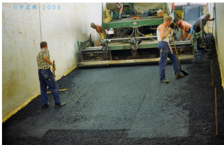
figuur A.1 FZK, Bau des Asphaltdeichs, Bild 3.jpg
