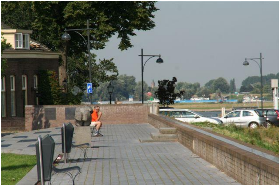
Figuur A.5 Waalkade Zaltbommel. Rechts: een lage muur om uitzicht op de rivier te behouden, te verhogen met flexibele kering tijdens MHW. Midden: de muur op de juiste hoogte. Links van deze muur: coupure naast een huis met toegang tot parkeerterrein buitendijks (zie ook Google Earth overzicht).
