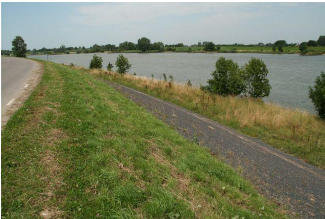
Figuur A.36 Lek bij Tienhoven. Direct aan de rivier. Talud rivierzijde bekleed met asfalt. Tot de hoogwaterlijn(?).
