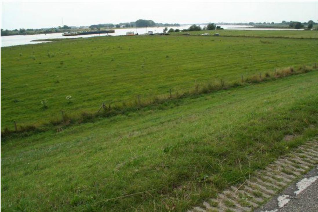
Figuur A.29 Noordzijde Waaldijk bij Lingewaal. Buitentalud gras. Weg op de kruin van de dijk. De auto's op de foto zijn daar gekomen via de afrit op de foto van pagina 15.
