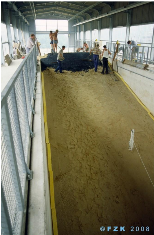
FZK, Bau des Asphaltdeichs, Bild 1.jpg
