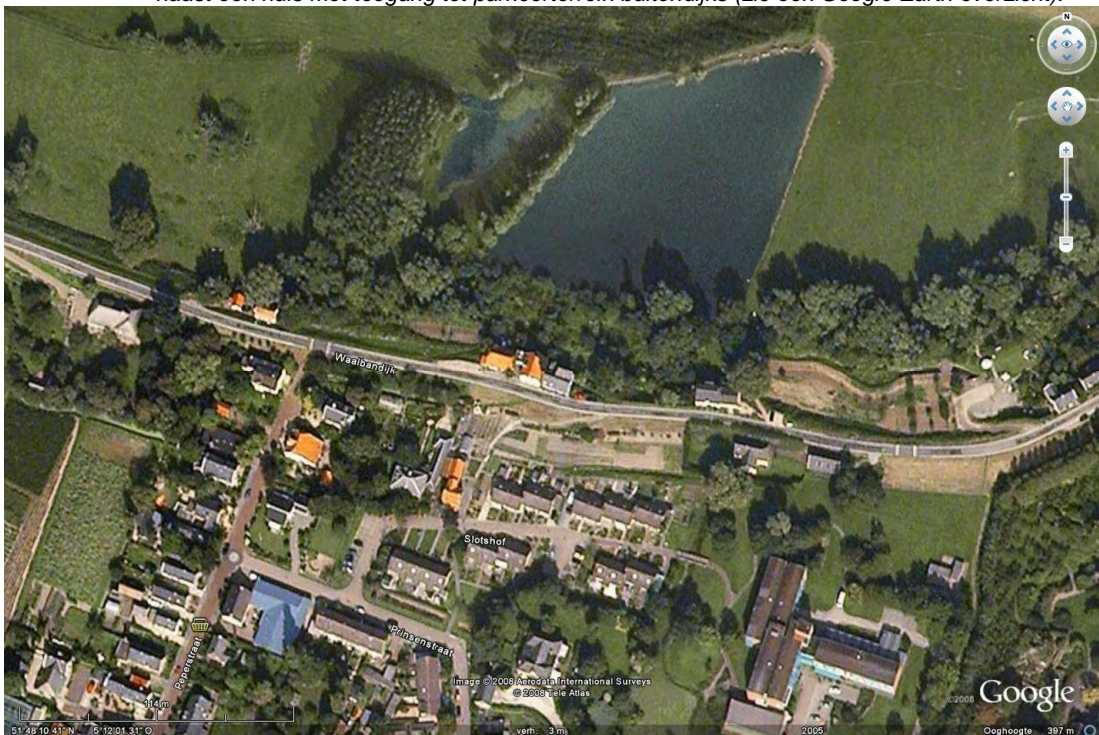
Figuur A.6 Bandijk langs de Waal bij Zaltbommel. De primaire kering loopt ten noorden van de bandijk. De bandijk is dus niet meer in functie als primaire waterkering.
