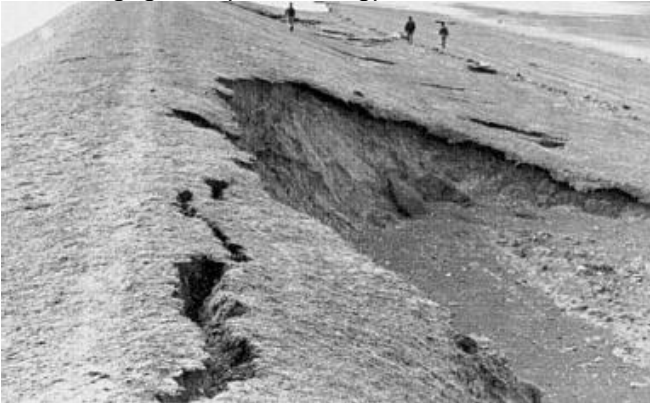
Figuur 3.8 Schade aan het buitentalud door golven; Duitsland 1962 (Kortenhaus et al., ICCE 2002)
