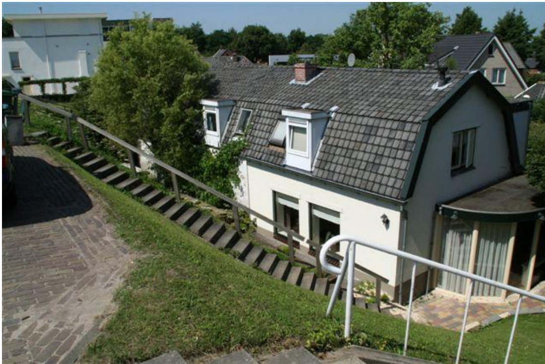
Figuur A.25 Hardingsveld-Giessendam. Bebouwing langs de binnenzijde. Oude bebouwing laag op het binnentalud. Nieuwe of verbeterde bebouwing (links-boven op foto) moet zo hoog zijn dat een volgende ronde dijkverbetering geen consequenties heeft.
