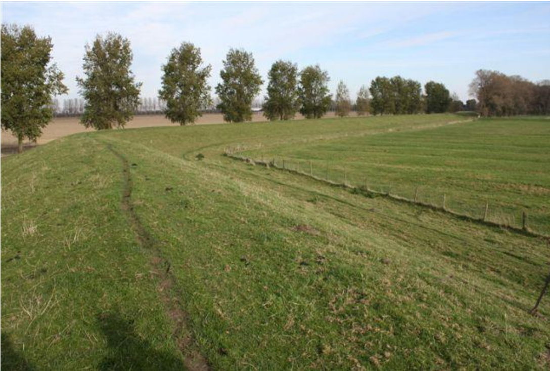
Figuur A.58 Hollands Diep. Recht stuk na de bocht aan het oostelijk deel van het rechte dijkvak. Rivierzijde aan de rechterkant.
