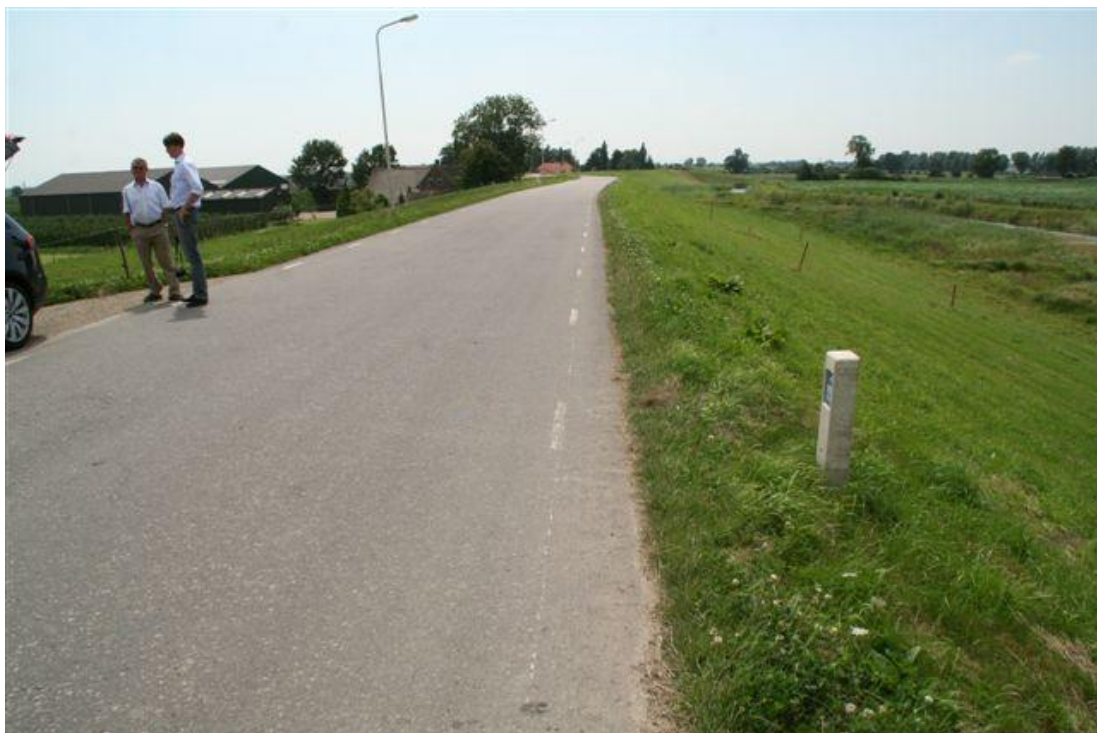
Figuur A.38 De Lek bij Achthoven. Paal VY093. Groen buitentalud met weg op de dijk.
