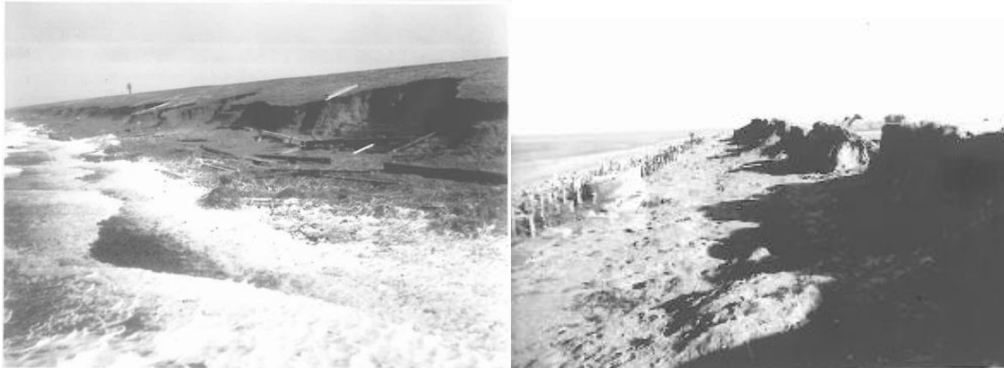
Figuur 3.9 Beschadigde dijk op Nordstrand (storm 16.2.1962)
