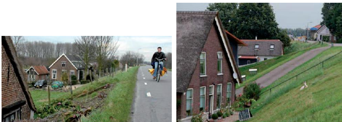
Figuur 2.10 Rivierdijk met weg, bebouwing en opritten
