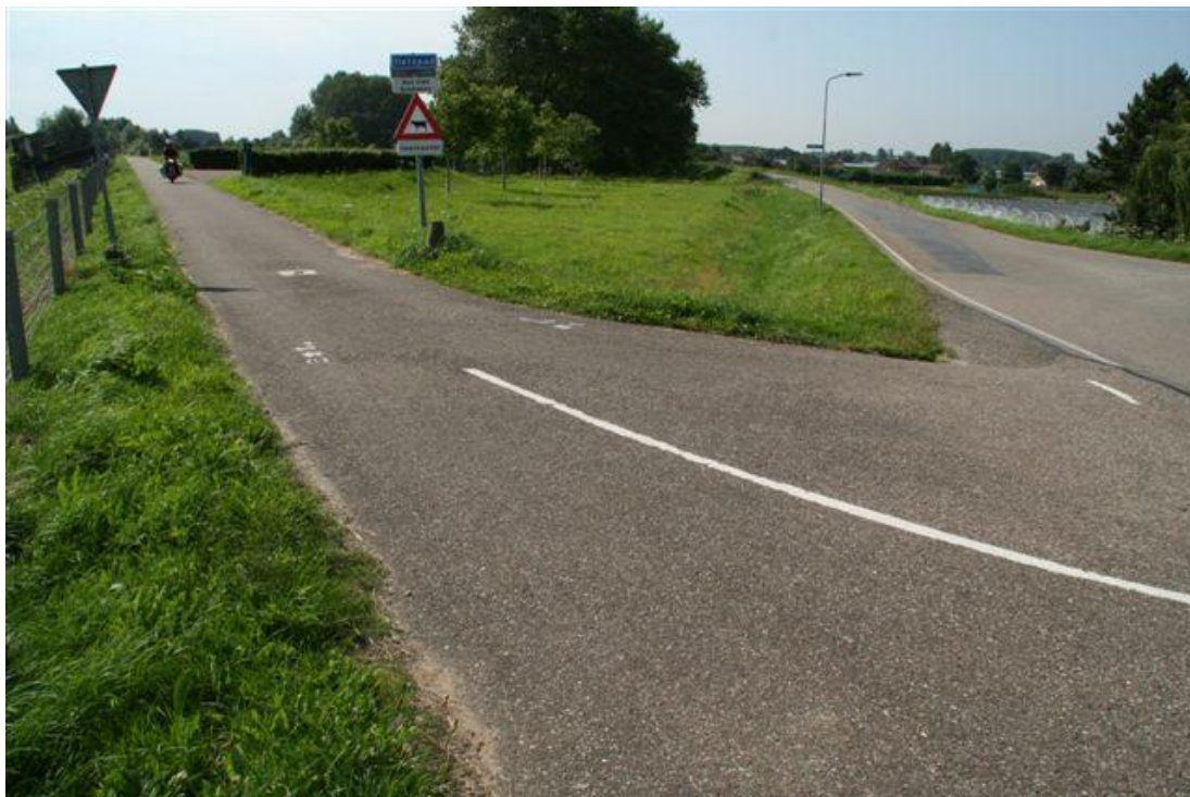
Figuur A.10 Aansluiting bandijk langs de Waal bij Zaltbommel. Rechts de banddijk, links de primaire kering. Rivierzijde: afrastering rond of net boven MHW. Fiets/brommerpad op de dijk.
