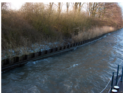
Figuur 2-6: Voorover hellen damwand
