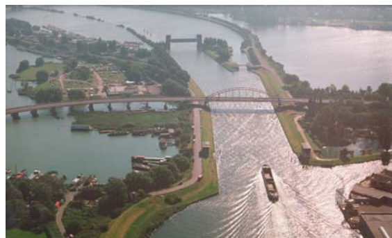
Figuur 2-2: Kering en sluiseland Zeeburg
