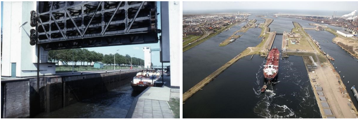
Figure 1.22: Left: Lock in the River Maas at Lith ( https://beeldbank.rws.nl , Rijkswaterstaat, by: Hans van Oostveen); right: Sea lock complex at IJmuiden ( https://beeldbank.rws.nl , Rijkswaterstaat, by: Fotostudio Honing Beverwijk).
