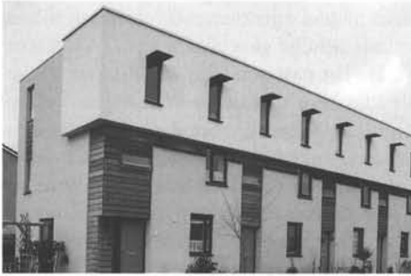
Afbeelding 3.22 Materiaalgebruik gevels Hengelo
