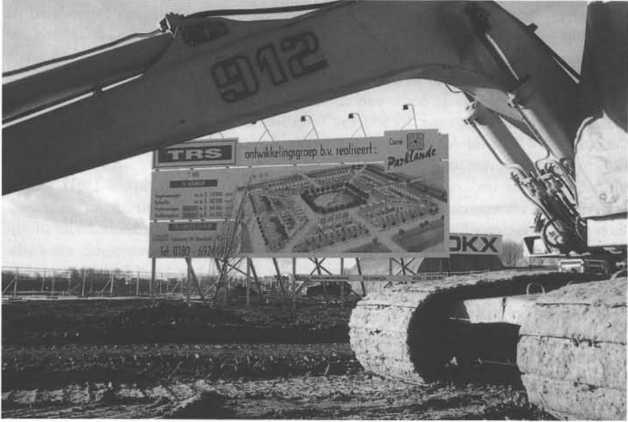
Afbeelding 3.1 Carré Parklande Carnisselande, werk in uitvoering
