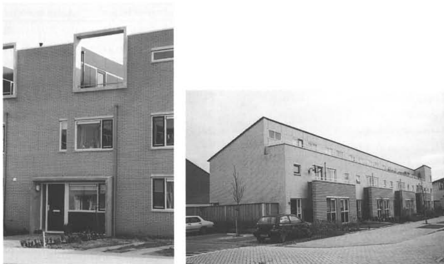
Afbeelding 3.16 en 3.17 Dakterrassen in Zwolle en Hengelo
