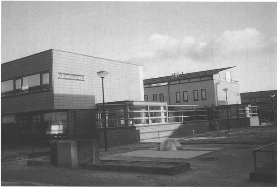
Afbeelding 3.11 Langzaam-verkeersroute/speelplaatsje Wateringse Veld
