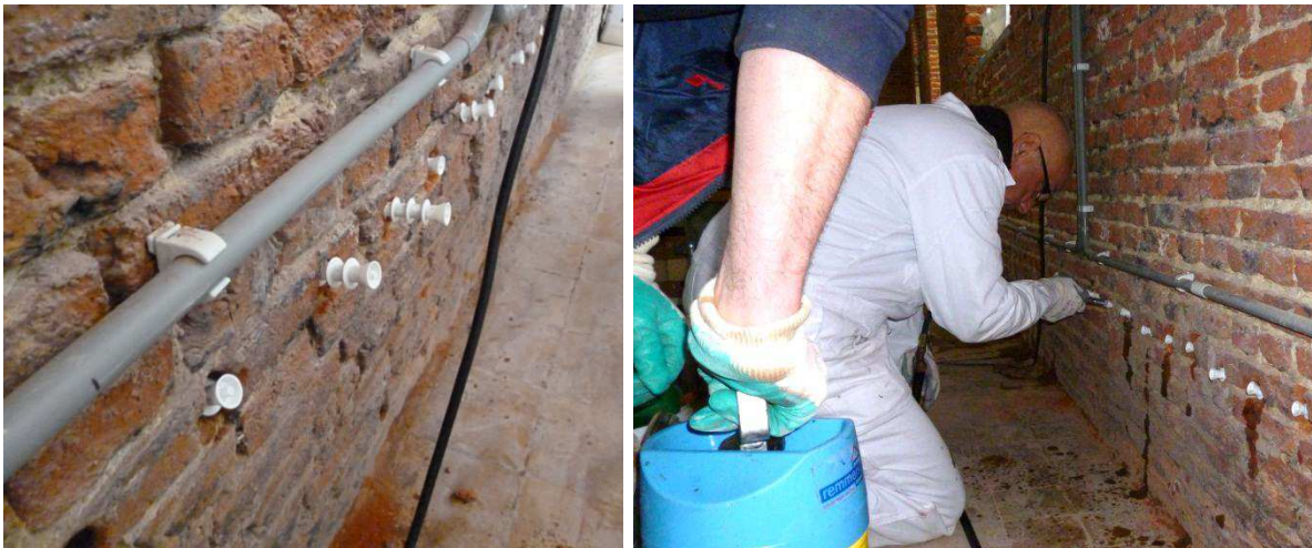
Fig. 2. Packers voor injectie met druk (links) en injectie van een vloeibaar product met druk (rechts).
