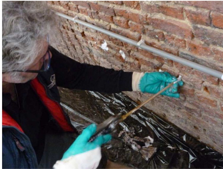
Fig. 3. Applicatie van een crème in metselwerk.
