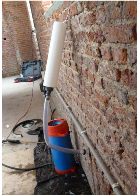
Fig. 1. Applicatie van een vloeibaar product onder hydrostatische druk.
