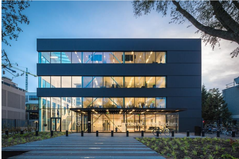
Figure 6: Temporary courthouse in Amsterdam (Bouwen met Staal, 2017)
