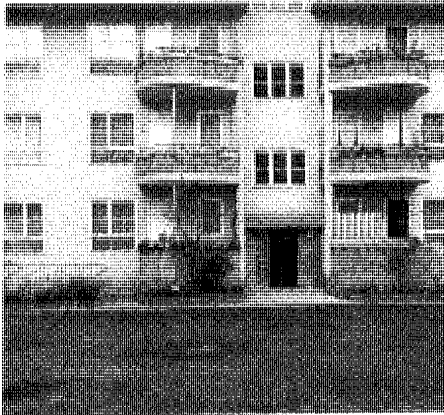
Balkons woningbouw Siemenstadt, Häring.
