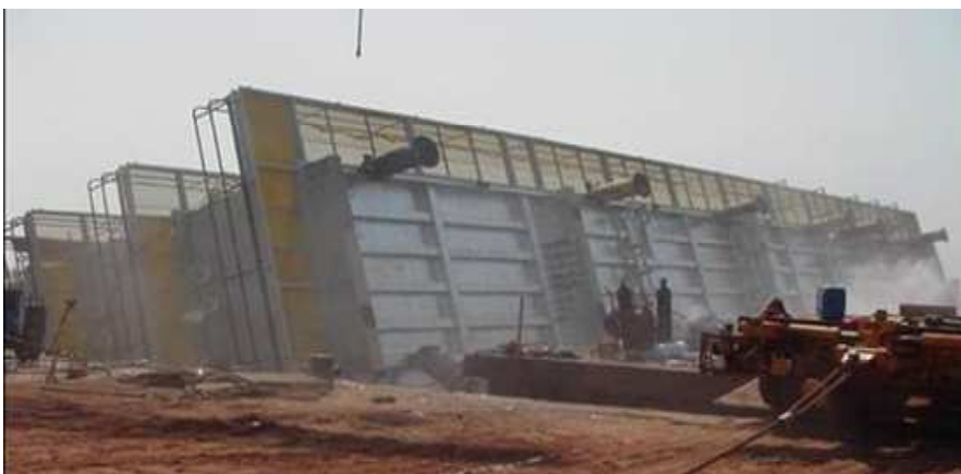
Afbeelding 8a en 8b: Module loadout die fout gaat.....
