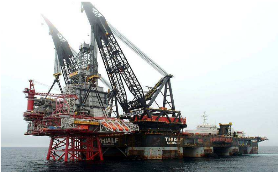
Afbeelding 5: Plaatsing van module op de onderbouw.
