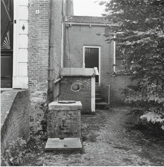
Fig. 8 Two regenputten (rainwater wells) connected to a rainwater pipe. Source Rijksdienst voor het Cultureel Erfgoed; released under a Creative Commons Attribution-NonCommercial-NoDerivatives 4.0 International License
