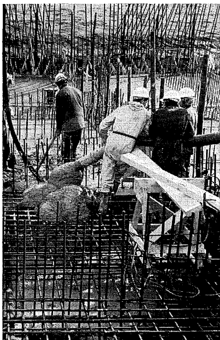
Betonneren van de vloerconstructie Casting the floor structure foto: Cement/Bob de Ruiter
