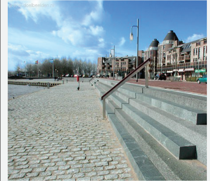
Image 5.4.8: Lowered waterfront in Almere haven, Almere (Doelbeelden.nl, s.d.).
